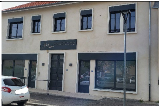
Locaux du SEMO de Château Arnoux
