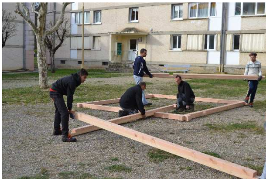
Sur un espace dénudé, avec les techniciens les jeunes construisent...
